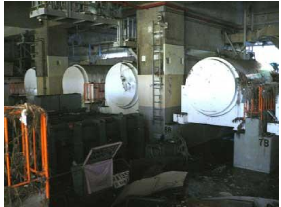
津波後の福島第一原発の使用済み燃料キャスク
