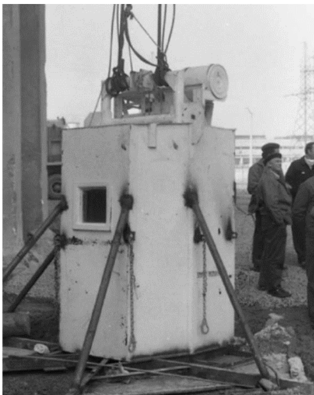
チェルノブイリでは、高線量の原子炉を覗くための「潜水艇」が使われたが…
